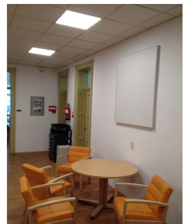
Abb. 13: Wandabsorber zur besseren Sprachverständlichkeit
